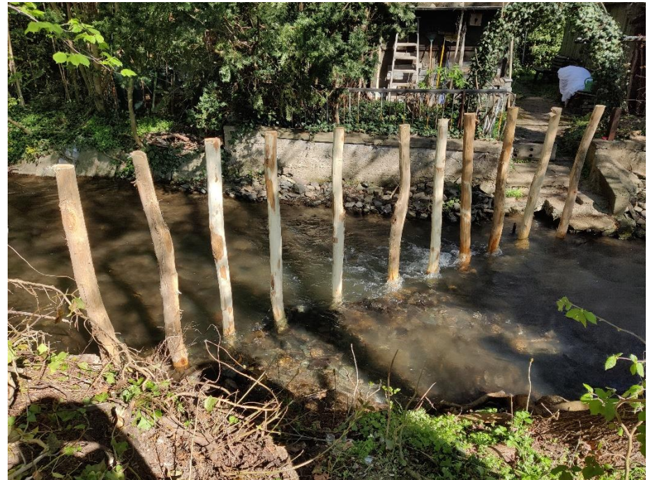
Foto: Treibholzsperrre am Aubach in Niederbieber, Quelle: BCE
