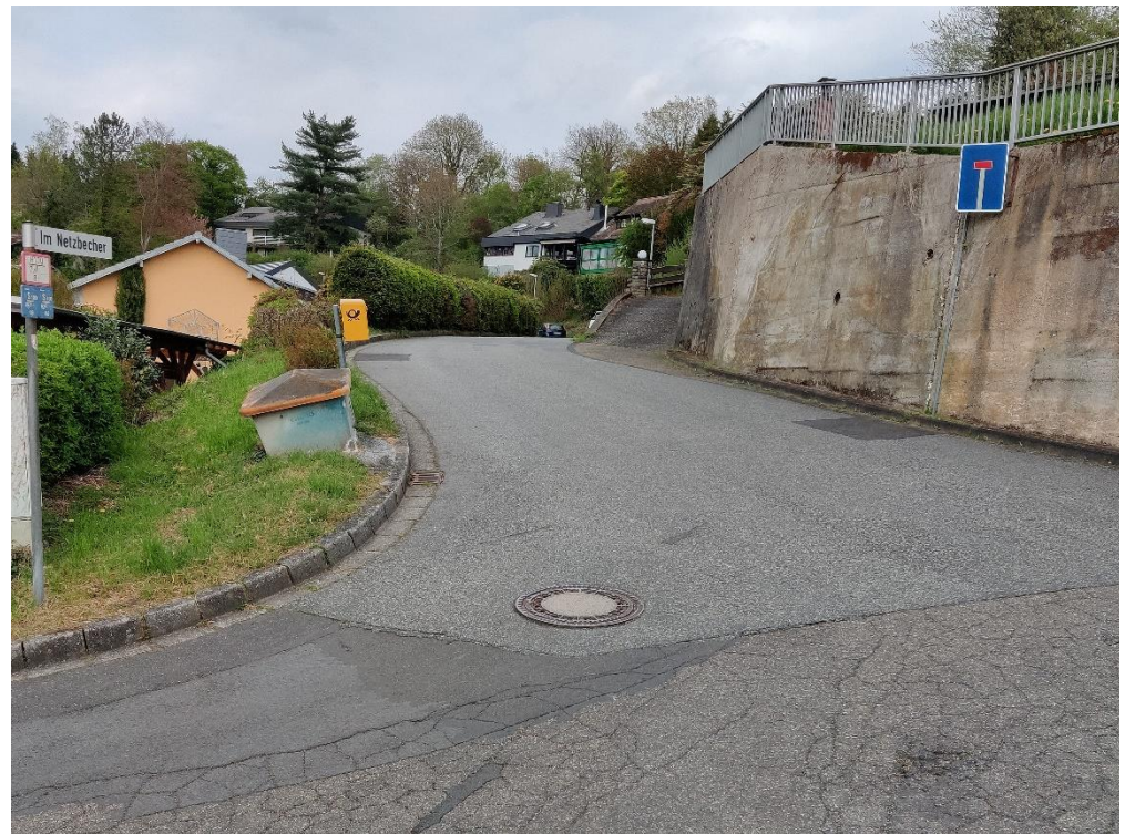
Foto: Straße Im Netzbecher Altwied, Quelle: BCE
